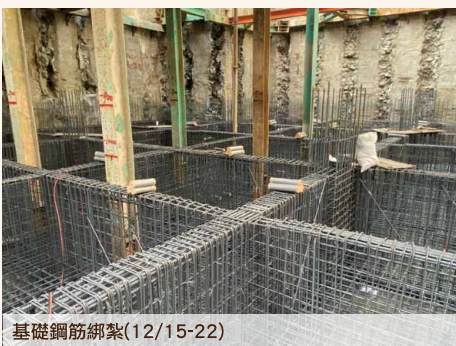
基礎鋼筋綁紮(12/15-22)
