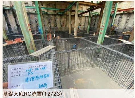
基礎大底RC澆置(12/23)
