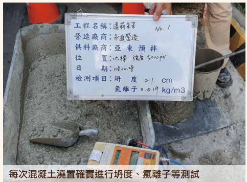
每次混凝土澆置確實進行坍度、氯離子等測試
