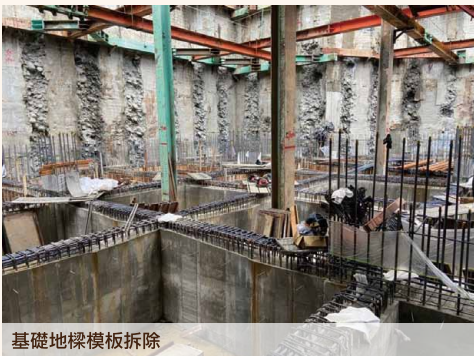
基礎地樑模板拆除
