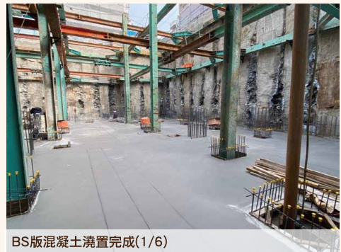
BS版混凝土澆置完成(1/6)
