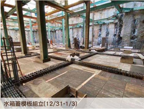
水箱蓋版模板組立(12/31-1/3)
