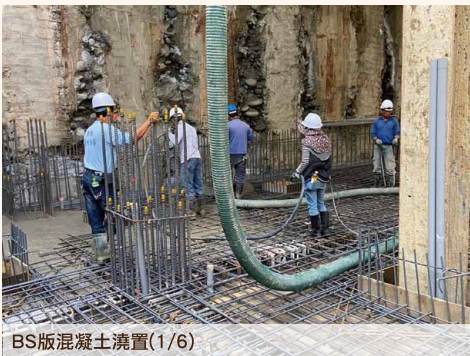
BS版混凝土澆置(1/6)
