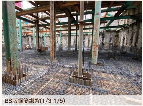
BS版鋼筋綁紮(1/3-1/5)
