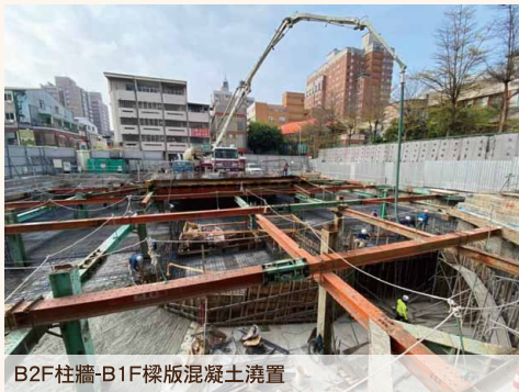
B2F柱牆-B1F樑版混凝土澆置完成
