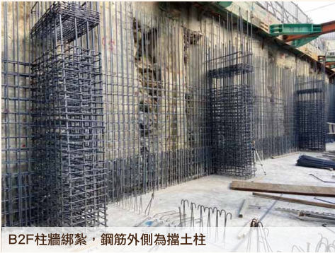
B2F柱牆綁紮，鋼筋外側為擋土柱
