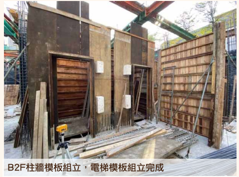
B2F柱牆模板組立，電梯模板組立完成
