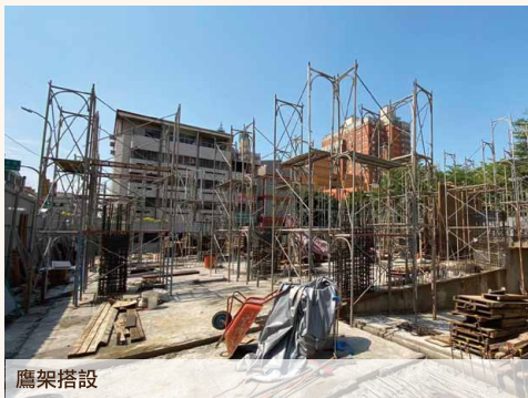
1F柱牆鋼筋綁紮、模板組立
