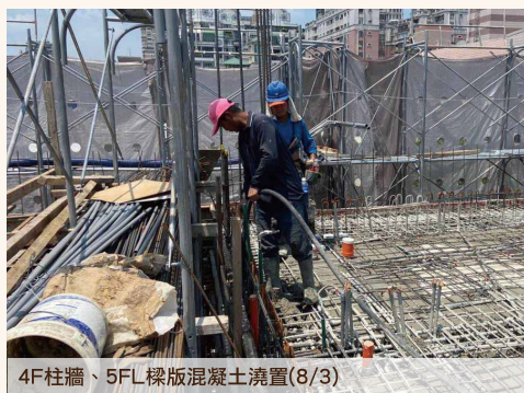
4F柱牆、5FL樑版混凝土澆置完成(8/3)
