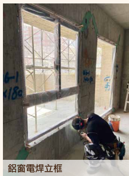
鋁窗電焊立框完成
