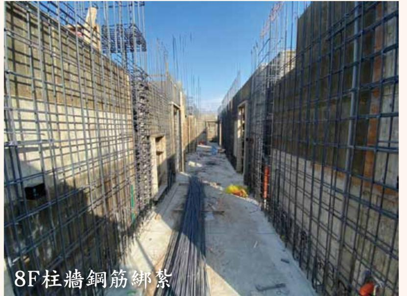
11月上旬進行8F單面模板組立、柱牆鋼筋綁紮。
