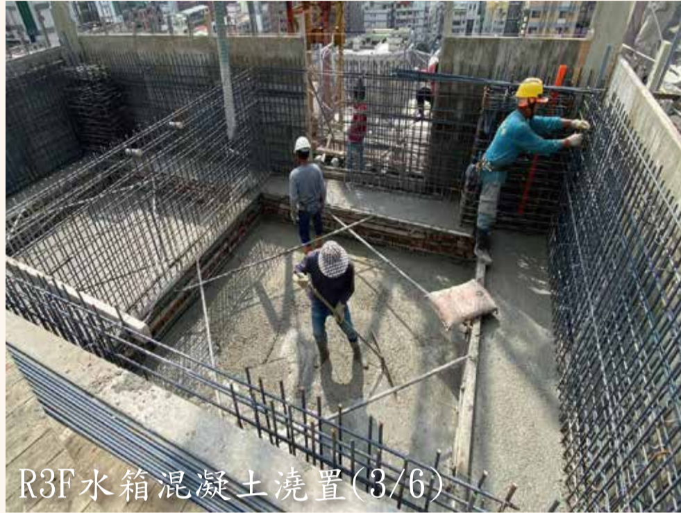
R3F水箱混凝土澆置(3/6)
