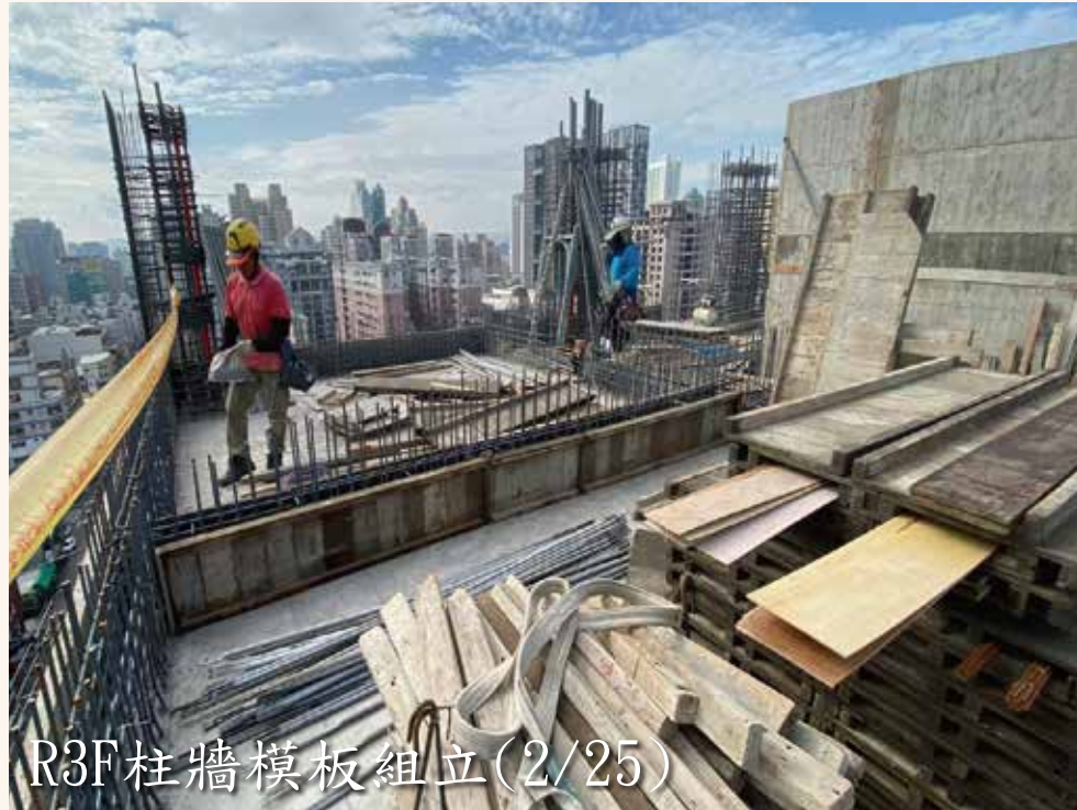
屋突層造型柱模板組立(2/25)
