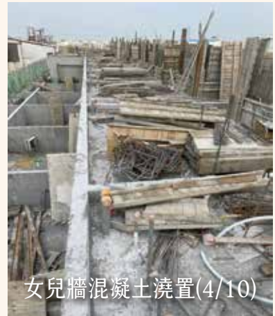
女兒牆混凝土澆置(4/10)
