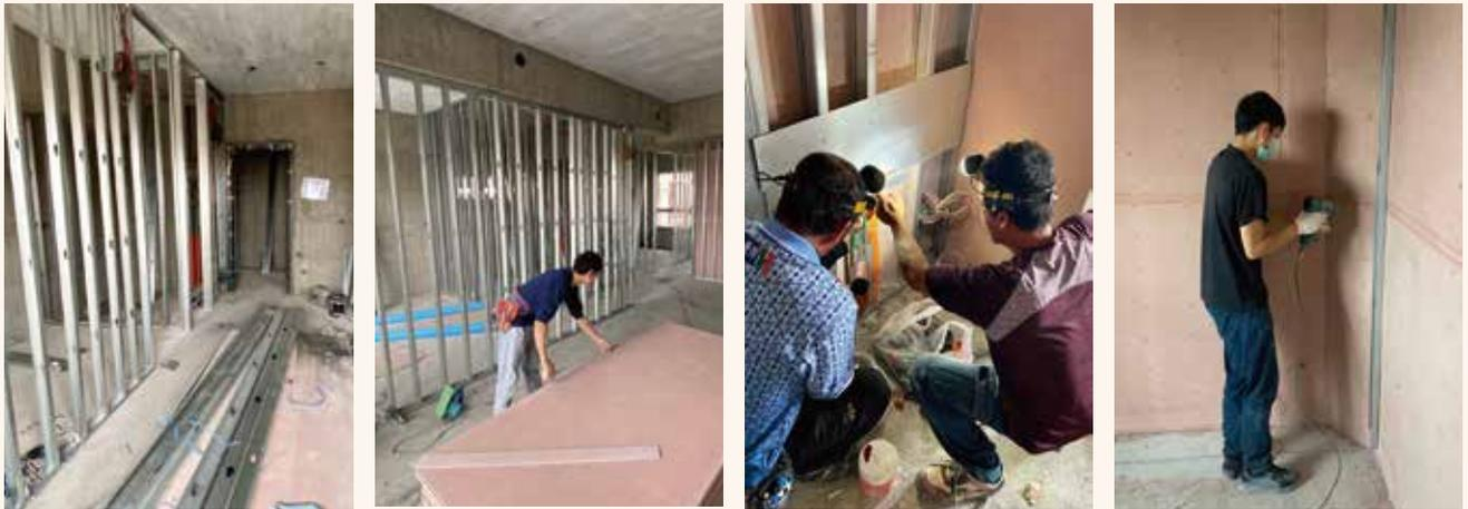
依據放樣位置固定上下槽後，安裝輕隔間骨料立柱，並鋪釘板片進行單面封版。單面封板完成後，進行水電管路放樣及固定，避免灌漿時位移。配管完成後使用自功螺絲將板片與立柱繫結鎖緊，並接續灌漿完成隔間工程。
