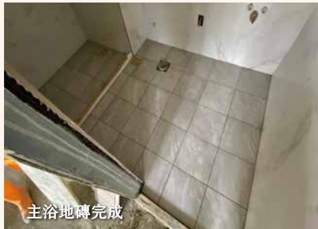
浴室壁磚完成後，接續進行浴室地磚施作。以水泥砂漿攪拌均勻後整平，並依序鋪貼浴室地磚，施作前再次丈量，確認磁磚分割及需裁切尺寸。貼上地磚後以槌柄輕敲使其順利吃漿，並確認其接縫平整度。地磚鋪貼完成間隔24小時後，進行填縫及擦拭，完成地磚工程。
