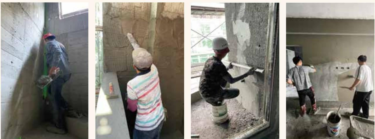
結構體完成後，利用雷射儀器量測牆面水平直角，貼條及施作灰誌，作為後續打底之基準。依據前述放樣基準，塗抹黏著劑後進行水泥砂漿打底，使牆面趨於平整。打底完成後，使用較細砂粒的水泥砂漿進行粉光，使牆面更加細緻。
