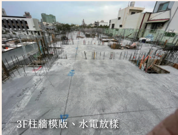
3F昇柱筋、污廢水管
