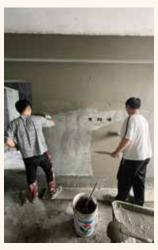
結構體完成後,利用雷射儀器量測牆面水平直角,貼條及施作灰誌,作為後續打底之基準。 依據前述放樣基準,塗抹黏著劑後進行水泥砂漿打底,使牆面趨於平整。 打底完成後,使用較細砂粒的水泥砂漿進行粉光,使牆面更加細緻。
