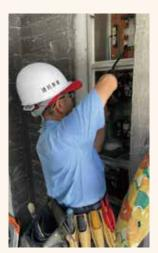
結構體完成後,於裝修工程期間檢核水電預留空間, 並進行電箱、插座、開關及等機電及弱電設備配線,完成房屋的神經網絡。
