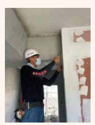
隔間工程與泥作工程完成後, 針對板片接縫處、螺絲孔位進行批土,並填平泥作牆面表面孔隙。 為提升上漆後美觀,於上漆前重複進行批土打磨,室內牆面逐漸完成。
