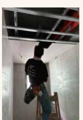
於浴室空間中,針對牆面與地坪進行防水施作。 防水工程完成後,磁磚進場施工放樣,於牆面以黏著劑背膠面貼壁磚及填縫。 浴室壁磚完成後,進行天花板工程,施作天花板骨架並接續進行封版, 過程中預留燈具及抽排風設備位置,完成後進行批土油漆。
