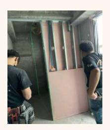
依據放樣位置固定上下槽後,安裝輕隔間骨料立柱,並舖釘板片進行單面封版。 單面封板完成後,進行水電管路放樣及固定,避免灌漿時位移。 配管完成後使用自功螺絲將板片與立柱繫結鎖緊,並接續灌漿完成隔間工程。
