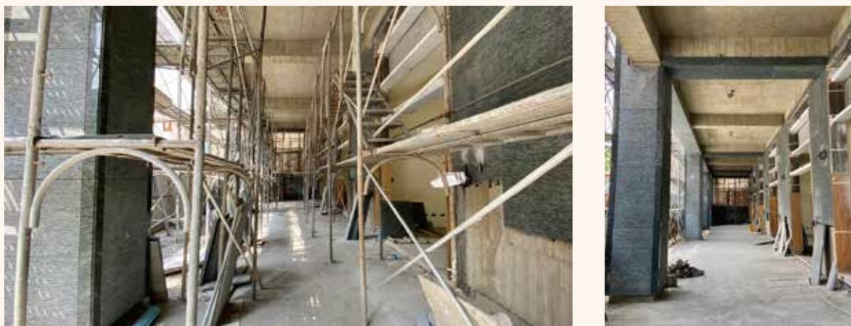
一樓基座外牆以石材為主，先行丈量放樣供石材加工，加工完成後於外牆進行吊掛施作。
