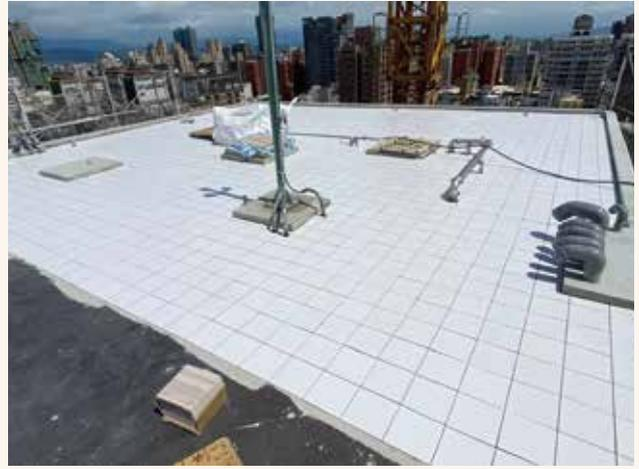
屋突外牆打底粉光後，接續進行設備工程及地磚工程。
