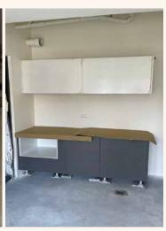
室內油漆完成後,廚具櫃體與設備準備進場。 於閣廚具自現場實際丈量後,依據各戶廚具設計圖面, 由工廠裁切進口板材,檢核水電預留位置並進行櫃體安裝。
