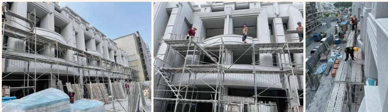
九月份外牆陸續裝修完成，開始進行鷹架拆除作業。
