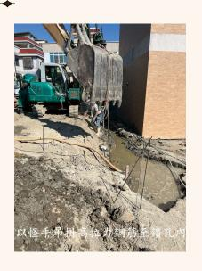
開挖前為保護鄰房地基安全,先行施作微型樁擋土工程; 鑽掘機鑽掘至設定深度後灌注水泥漿並置入高拉力鋼筋, 構成樁體以保護鄰房建築物安全。
