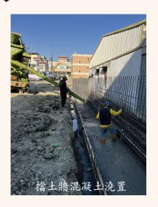
整地完成後考量施工安全及降低鄰損,先行施作東南向擋土牆,開挖至設定高程後,進行擋土牆基礎鋼筋綁紮與混凝土澆置,依序完成東南向擋土牆。
