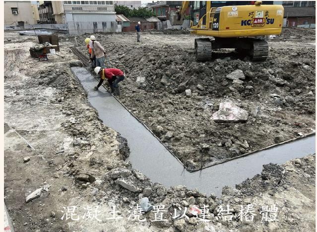
預壘樁及止水樁完成後，施作樁體頂層鋼筋綁紮及混凝土澆置之擋土壓樑，將預壘樁體連結成圍束作用。
