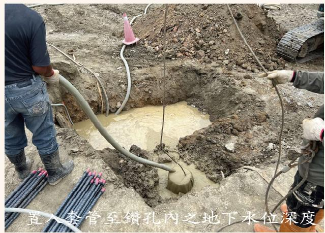
建築基地開挖前，於基地週邊施作點井工程並密切觀察地下水位的升降變化，以利後續開挖。
