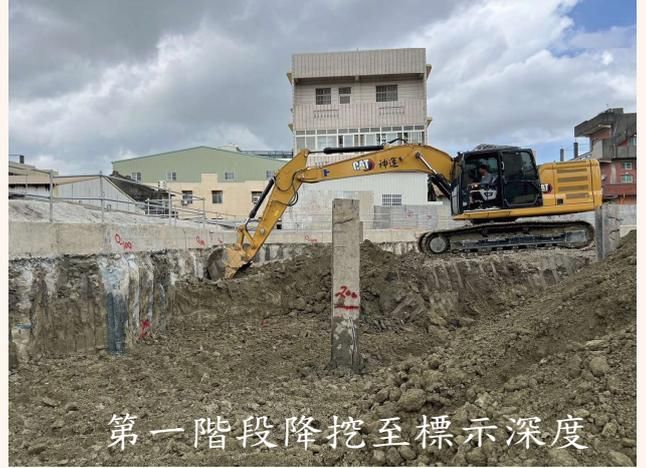
擋土壓梁及週邊點井工程施作完成後，開始第一階段出土降挖，地下室範圍內降挖至GL-2.9m，採一挖一撐工法。
